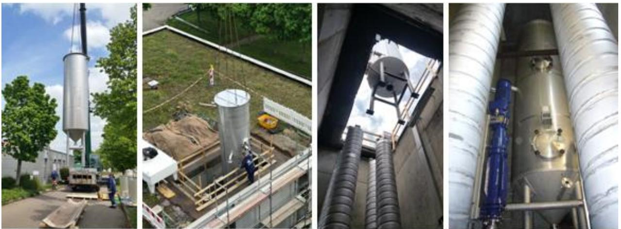
Abbildung 9: Einbringen der Pondus-Anlage ins Maschinengebäude (Mai 2019)
