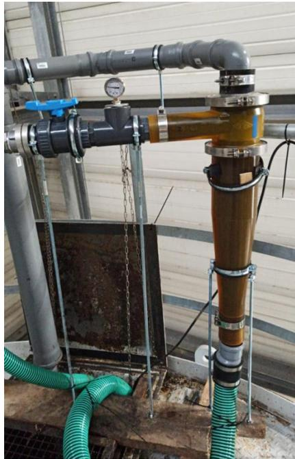
Abbildung 20: Hydrozyklon auf dem MAP-Reaktor (Juli 2022)
