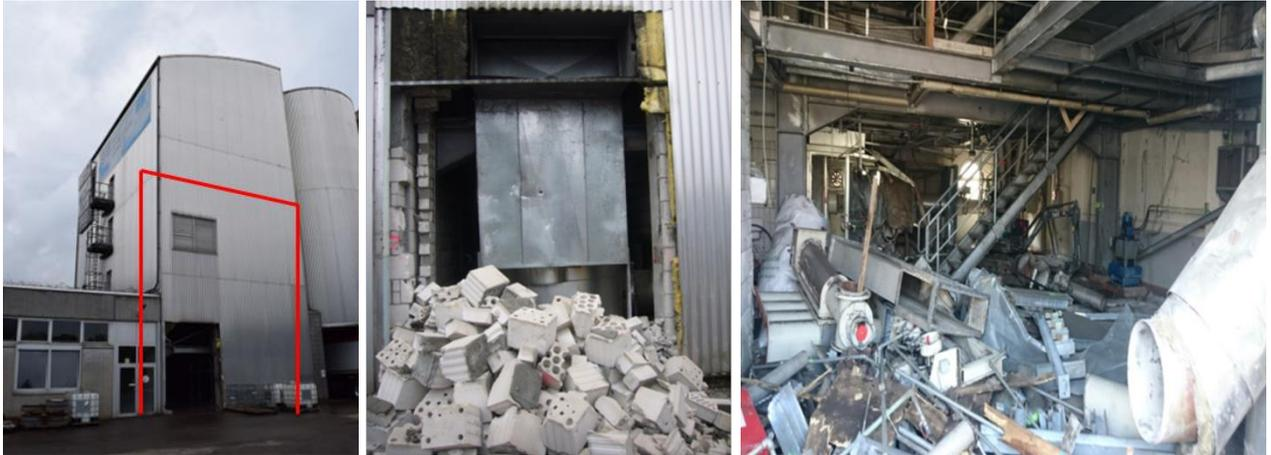
Abbildung 8: Herrichten der Trocknerhalle für die MAP-Anlage (März 2019)
