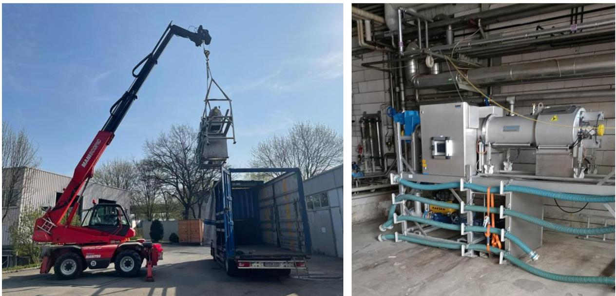
Abbildung 19: Aufstellen des Aggregats zur Schlamm-siebung (April 2022)
